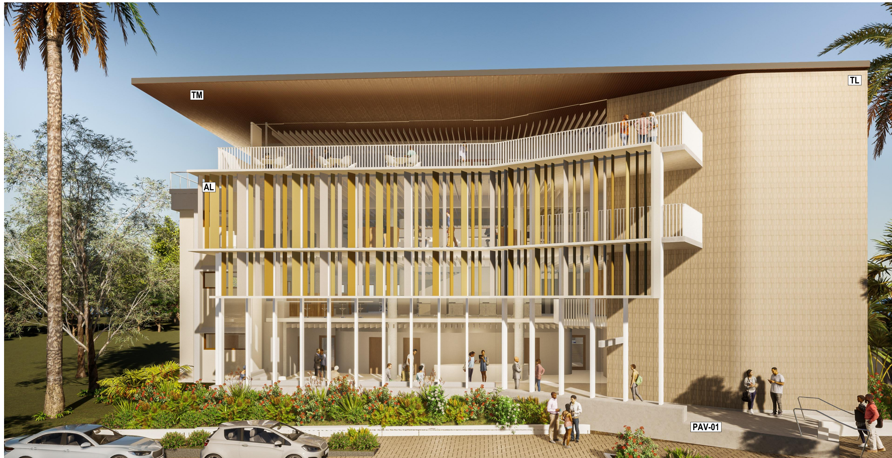
TM - TIMBER BATTEN SOFFIT
